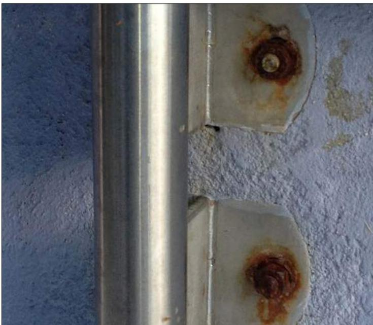
**Abbildung 3: Beispiel für Kontaktkorrosion, Edelstahlgeländer verzinkter Verschraubung**
