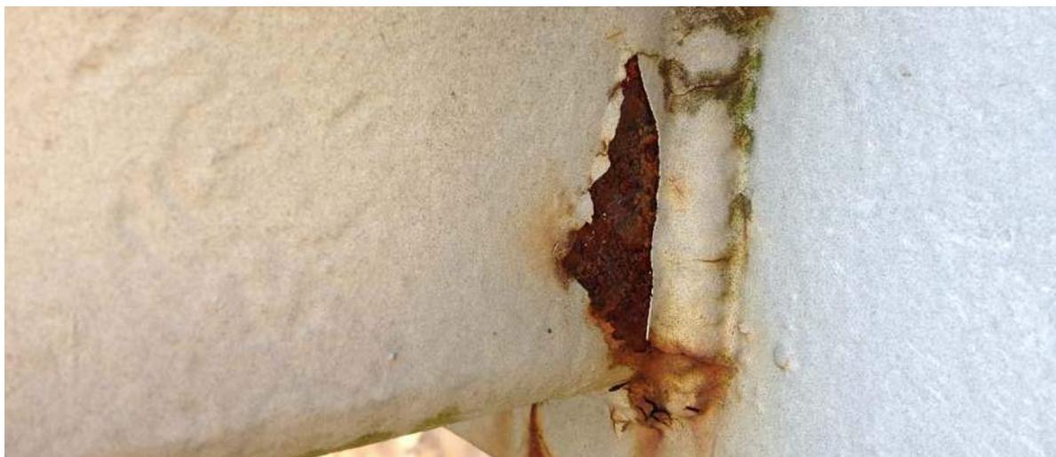
**Abbildung 13: Beschichtungsschäden an einer nicht ordentlich gereinigten Schweißnaht**
