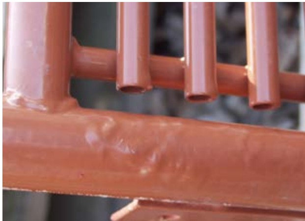
Abbildung 11: unverputzte Zinkverdükung
